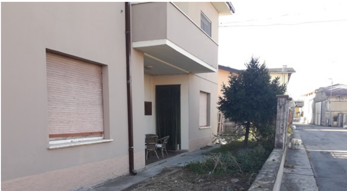
Foto 6: cortile lato ovest (vista da nord)
