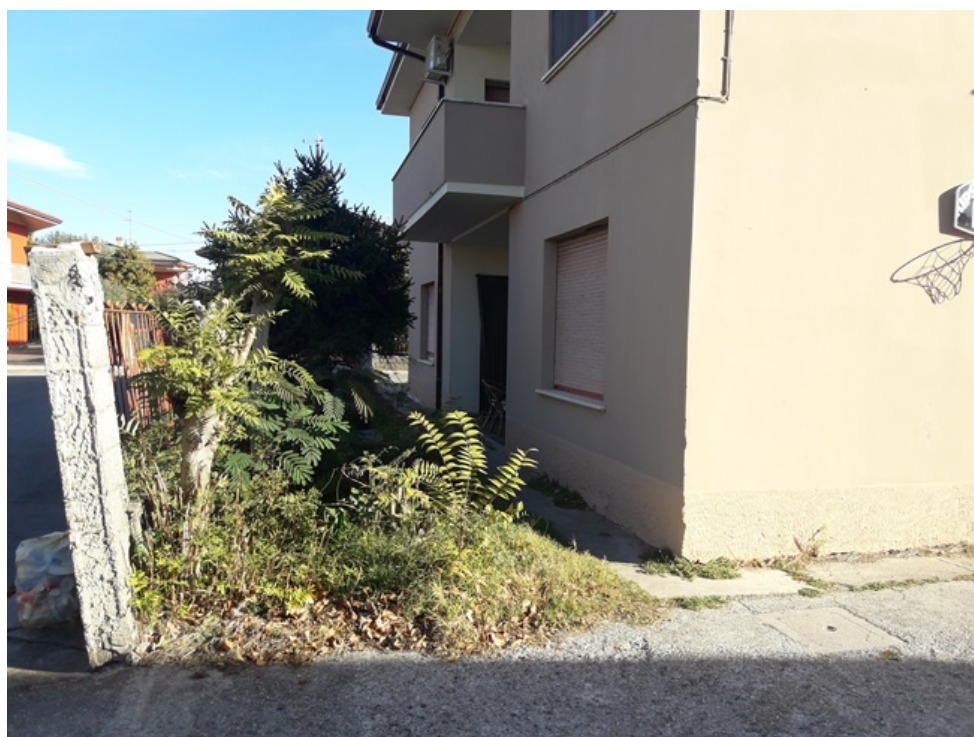
Foto 4: Cortile lato ovest (dettaglio recinzione)
